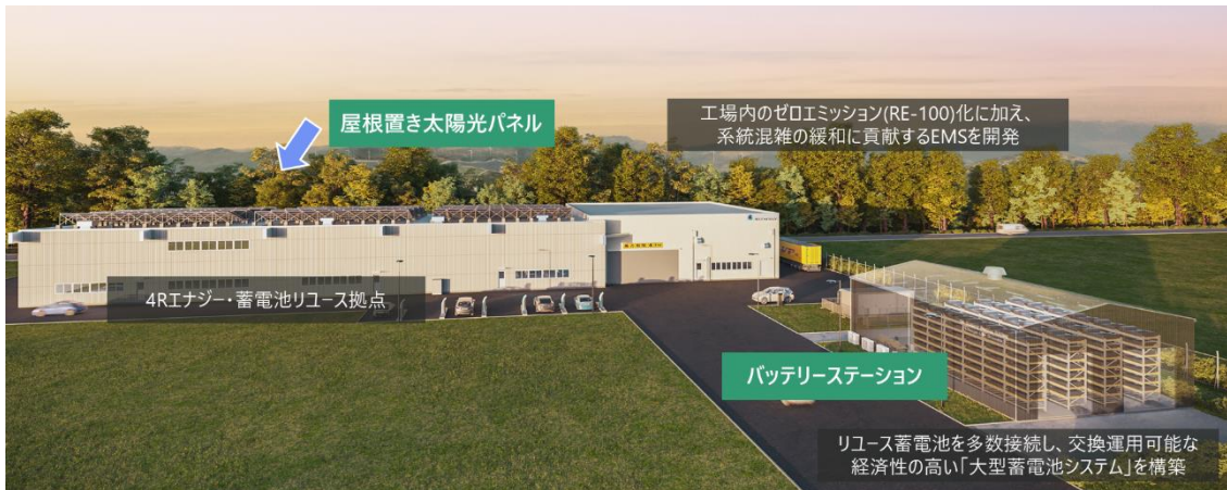
図 1 4R エナジー浪江事業所に設置する蓄電池システム（図右）・屋根置き太陽光発電
