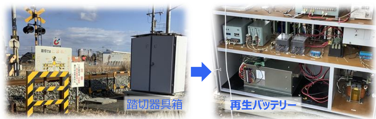
[再生バッテリーの設置状況]
